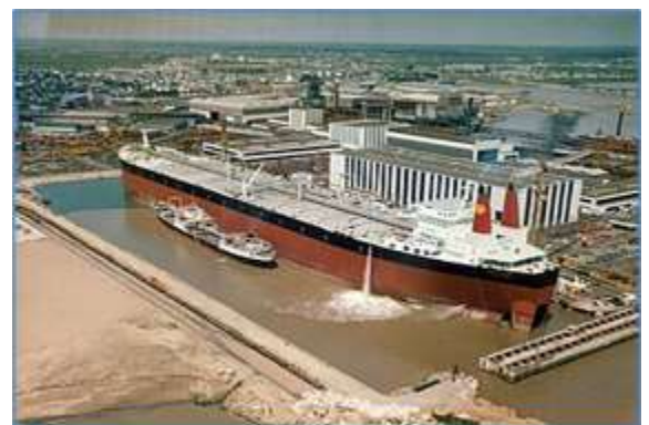
Le Batillus en fin de construction à Saint-Nazaire
