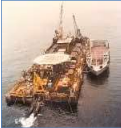
Les navires de première génération, tels que le DLB 23 de McDermott, étaient parfaitement adaptés au golfe du Mexique et non aux conditions difficiles de la mer du Nord
