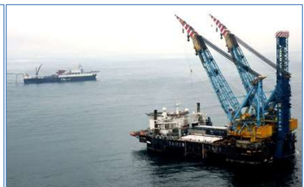
Navire de pose de canalisations J-Lay S7000
