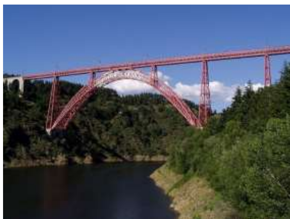
Le viaduc de Garabit.
