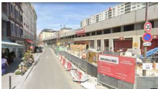
Chantier de reconstruction
