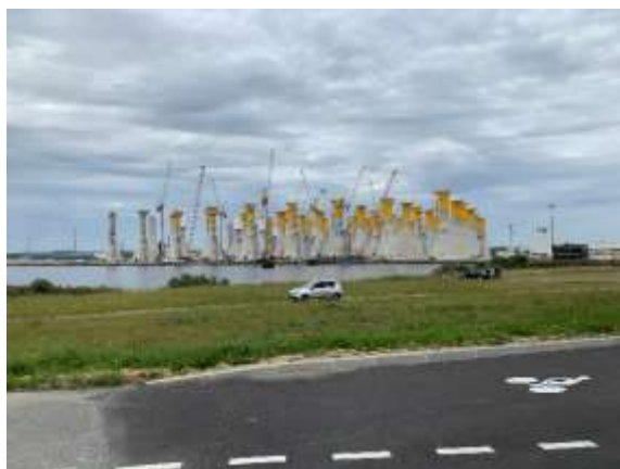
Chantier de fabrication des embases gravitaires
