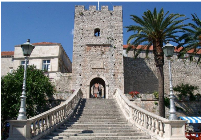
Porte d'entrée de la ville
