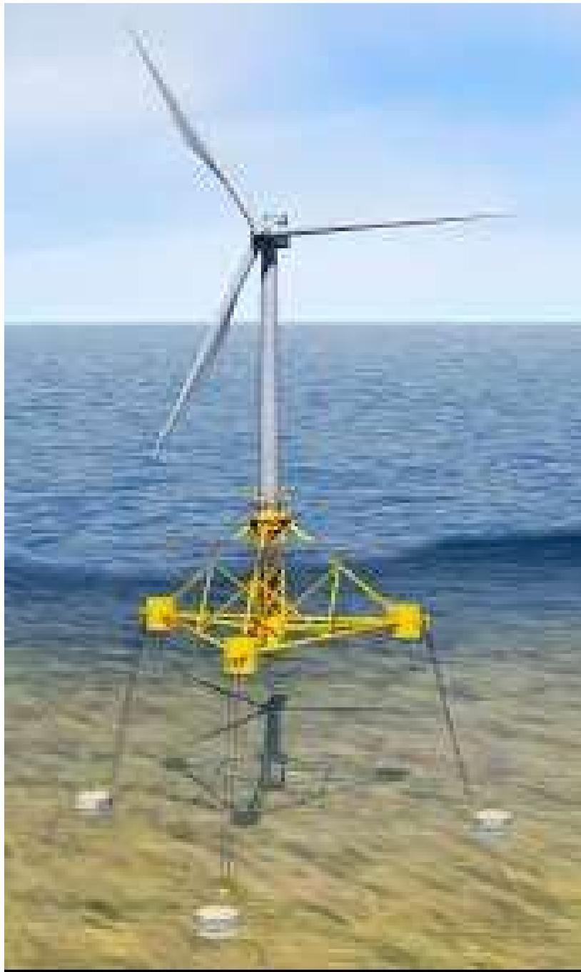
**Projet Grand Large (Turbine 8 MW) – Flotteur type TLP (IFP-EN/SBM)**
