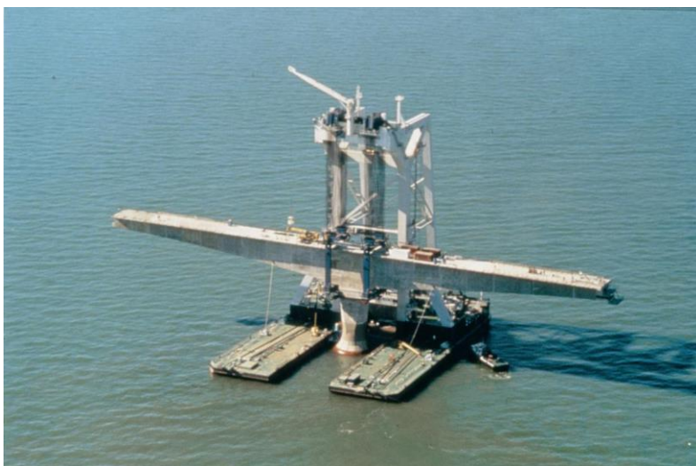
Pose d'un fléau de 200 m sur sa pile.
