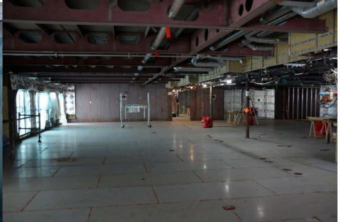
Espace appelé à recevoir les cabines préfabriquées ↑
