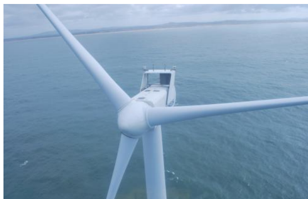
La turbine VESTAS de 2 MW
