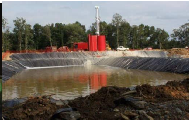
↑ celui-là : Bassin de récupération de l'eau salée
