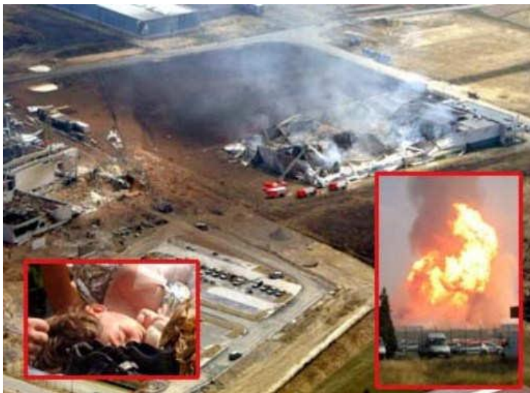
← Explosion d'un gazoduc enterré à Ghislenghien en Belgique (2004)
