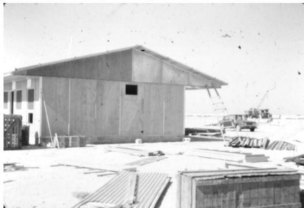
Figure 23 : Un logement de famille en fin de construction
