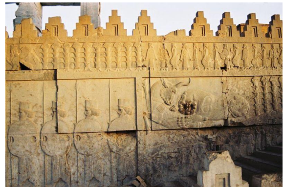
Figure 12 : Détail de l'escalier EST
