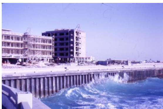
Figure 30 : La corniche en construction par SIX CONSTRUCT
