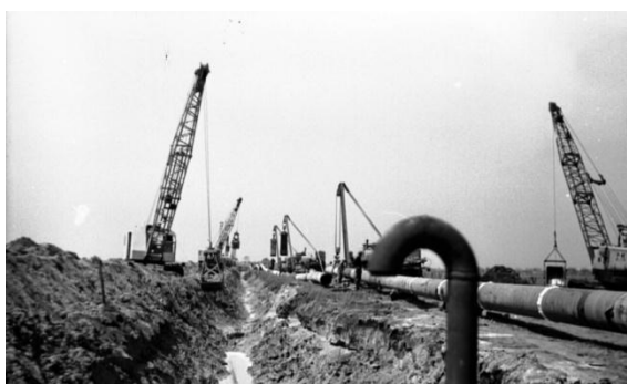
Figure 19 : La pose d'un pipeline en Hollande
